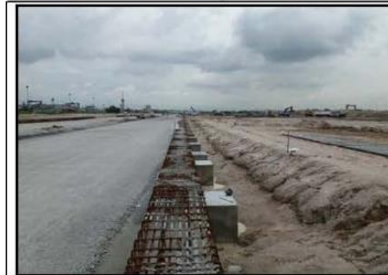
บริเวณสถานที่ก่อสร้างลานขนถ่าย
