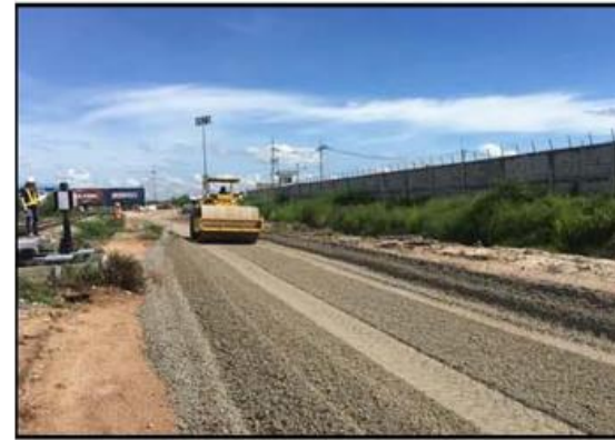
บริเวณสถานที่ก่อสร้างทางรถไฟ ทางคู่
