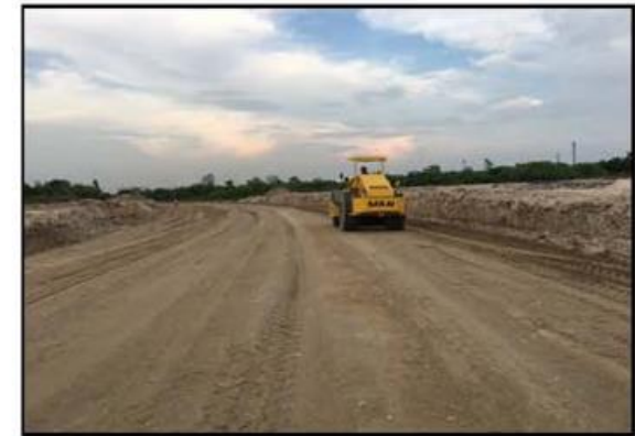
บริเวณสถานที่ก่อสร้างการบดอัดชั้นดินเดิมรางคู่
