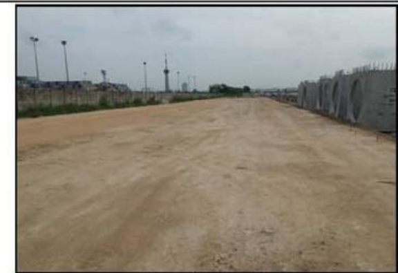
บริเวณที่ปรับพื้นที่ถนน B
