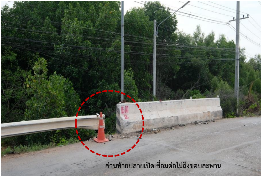
ส่วนท้ายปลายเปิดเชื่อมต่อไม่ถึงขอบสะพาน
