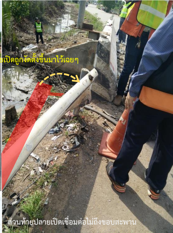
หลังจากชน ส่วนท้ายปลายเปิดถูกงัดตั้งขึ้นมาไฉ่เฉยๆ
