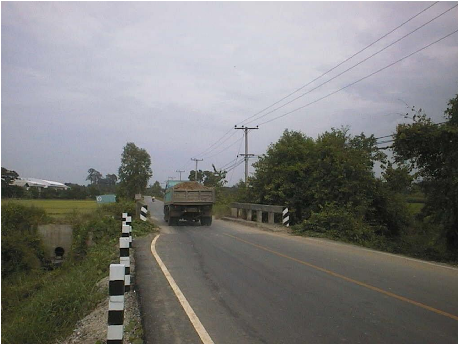
สองข้างสะพาน ถนนได้รับการขยาย สะพานยังกว้างเท่าเดิม และมีขอบทางเดินเท้าบนสะพาน เป็นวัตถุอันตรายอย่างหนึ่ง
